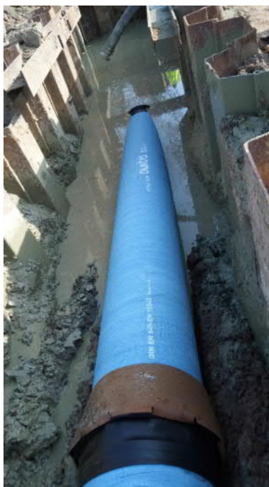
Figure 8: Fosse d'arrivée où la canalisation fonte ductile est tirée
