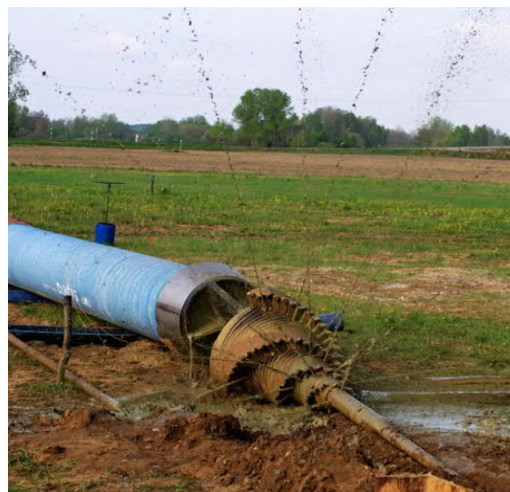
Figure 7: Raccordement de la tête d'expansion et de la tête de tirage après alésage et test de fonctionnement avant pose
