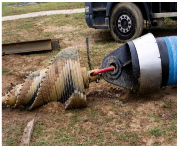
Figure 7: Raccordement de la tête d'expansion et de la tête de tirage après alésage et test de fonctionnement avant pose
